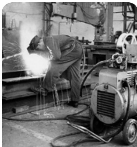
Einführung der CO 2 -Arc-Schutzgas-Schweißtechnik durch Ing. Erwin Cloos. Erstmaliges Schweißen mit endloser Drahtelektrode.
