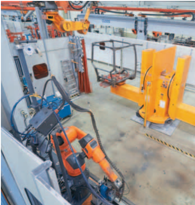
Alle Anlagen sind als Mehr-Stationen-Anlagen konzipiert
